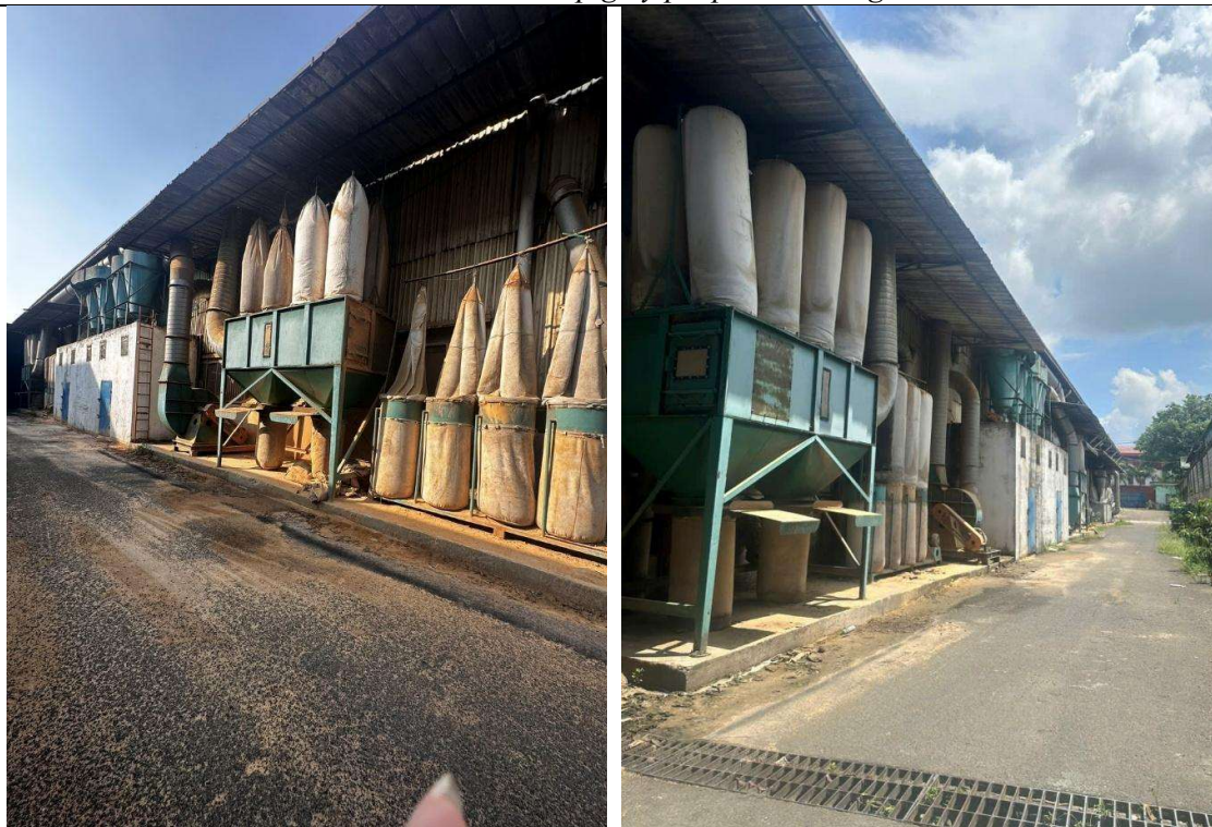
Hình 3.11: Hệ thống thu hồi bụi gỗ bằng túi vải
