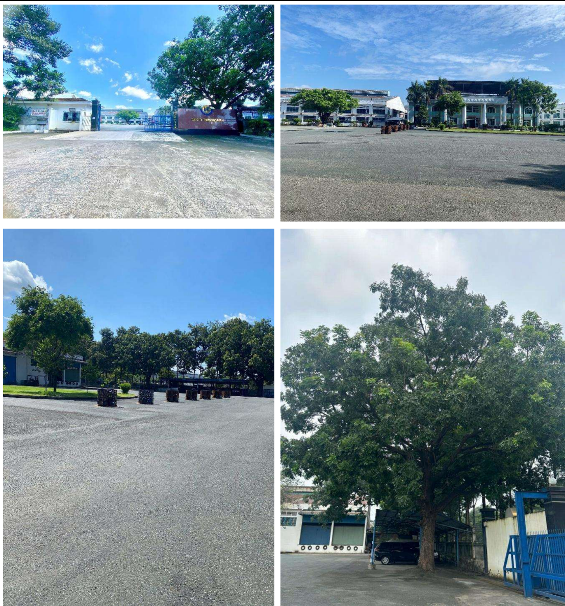
Hình 3.28: Cây xanh tại nhà máy
