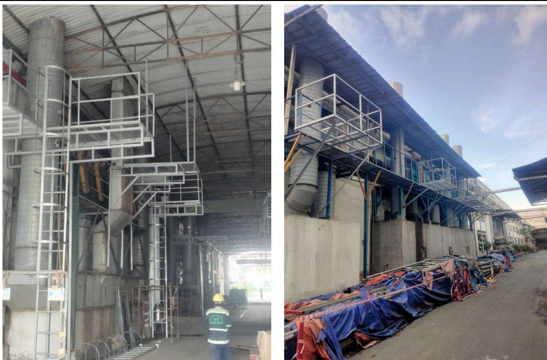
Hình 3.18: Hệ thống xử lý hơi dung môi bằng tấm lọc
